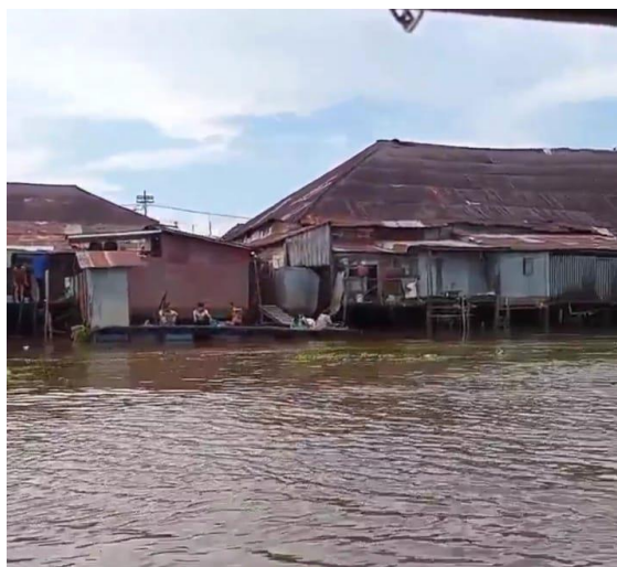
Gambar 1. Jamban Apung di DAS Martapura Banjarmasin
