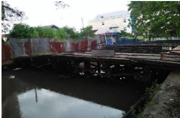
Gambar 2. Jembatan yang melintasi sungai di Kota Banjarmasin
